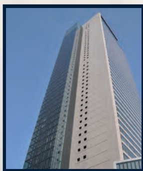
ミッドランド スクエア(約1,100m) ショッピングや映画などが楽しめる多彩な商業施設。5層吹抜のアトリウムや屋外展望台などの多彩な設備を備え、駅周辺に賑わいをもたらしています。
