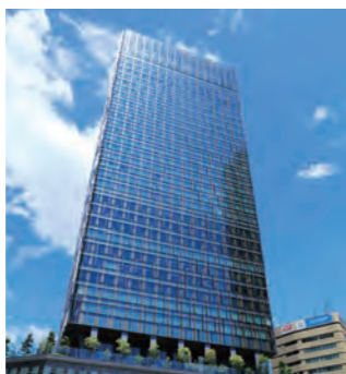
大名古屋ビルヂング (約2,200m) DAINAGOYA BUILDING
